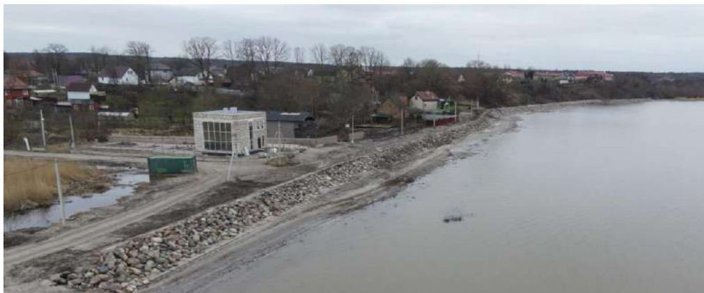
Рис. 3.21. Берегозащитное сооружение на побережье Калининградского залива в пос. Ушаково Гурьевского района Калининградской области
