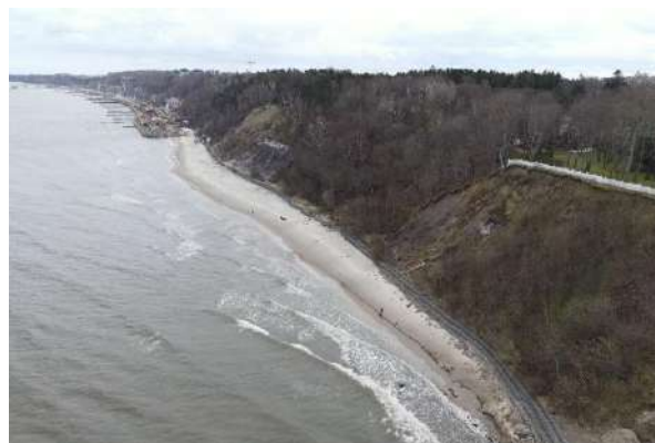
Б - Аварийный участок оползнеопасного берега в г. Светлогорск.
