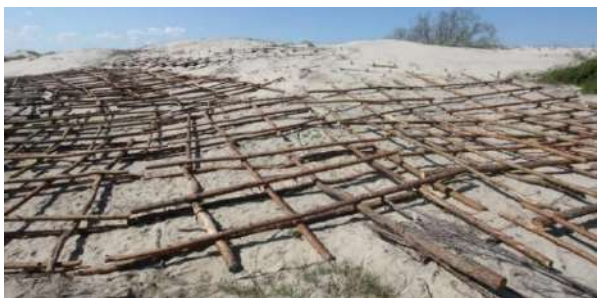
Рис. 7.6. Участок укрепления клетями для восстановления целостности авантюны
