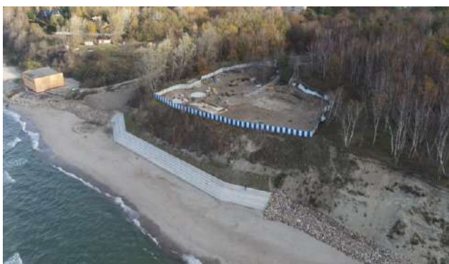
А - Подпорная стенка в районе очистных сооружений в пос. Янтарный
