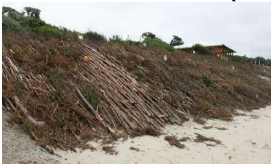
Рис. 7.8. Укрепление размываемого склона авантюны хворостом, пос. Лесной
