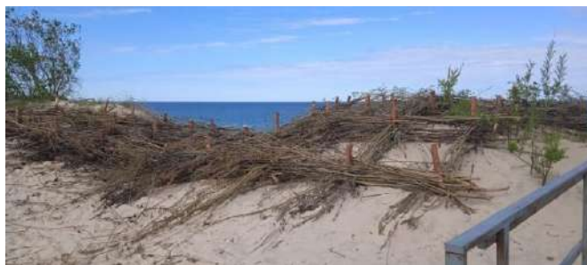
Рис. 7.7. Укрепление клетями с плетением на бровке авантюны, рядом со смотровой площадкой
