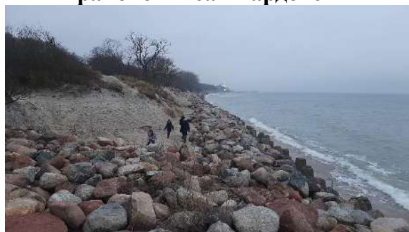
Е - Участок укрепленной авандюны в прикорневой части Куршской косы
