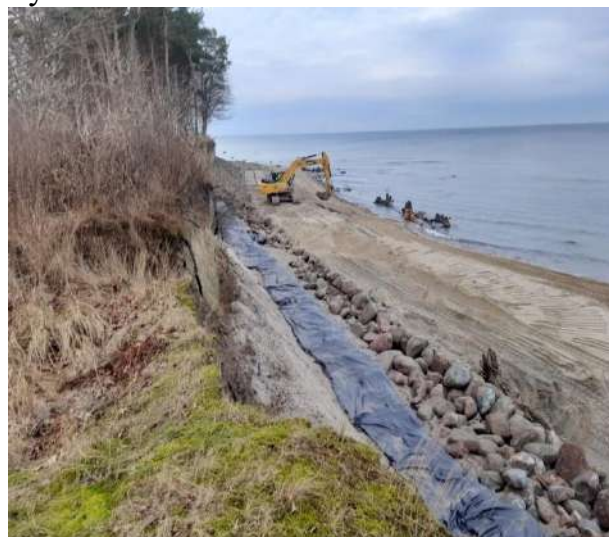
Б - Аварийно-восстановительные работы на участках берега Балтийского моря
