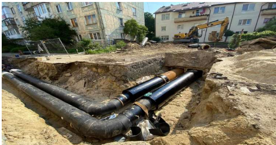
Рис. 13.1. Реконструкция участка сети городской дождевой канализации
