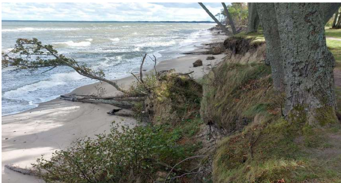
Рис. 3.14. Аварийный участок берега в районе пос. Куликово между р. Алейка и р. Забава
