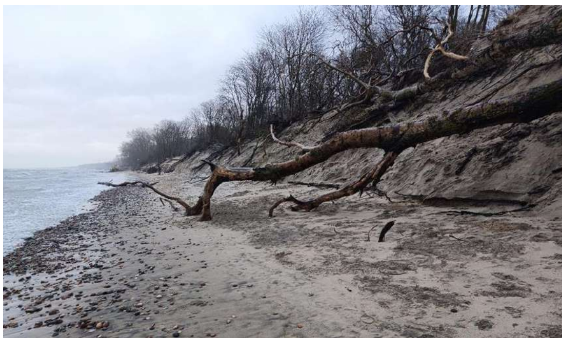
Рис. 3.15. Аварийный участок берега в восточной части г. Зеленоградска
