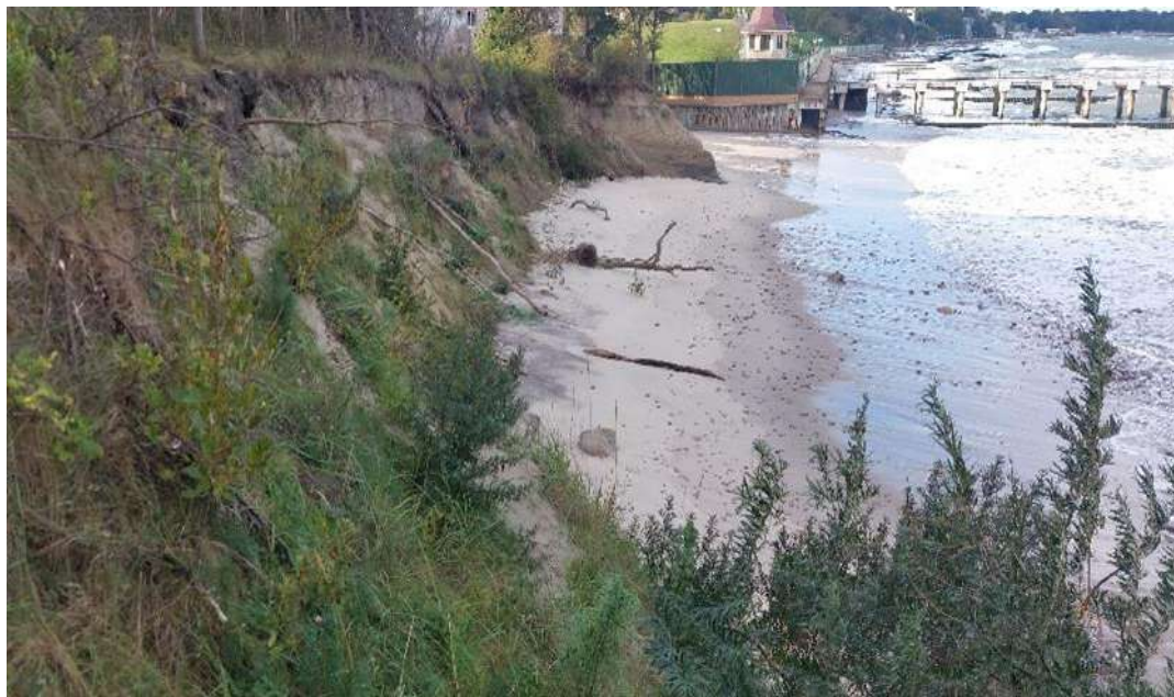
Рис. 3.11. Аварийный участок берега в районе лестничного спуска на пляж в п. Заостровье
