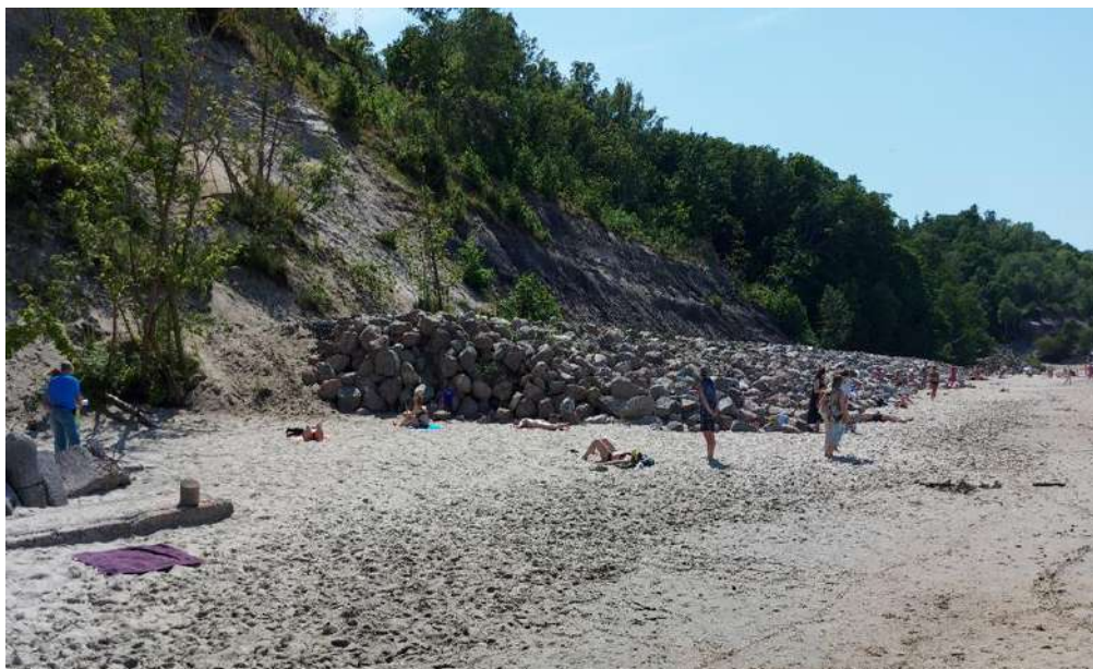
Рис. 3.8. Частично реконструированное берегозащитное сооружение в районе санатория «Янтарный берег» в г. Светлогорске (Опояска)
