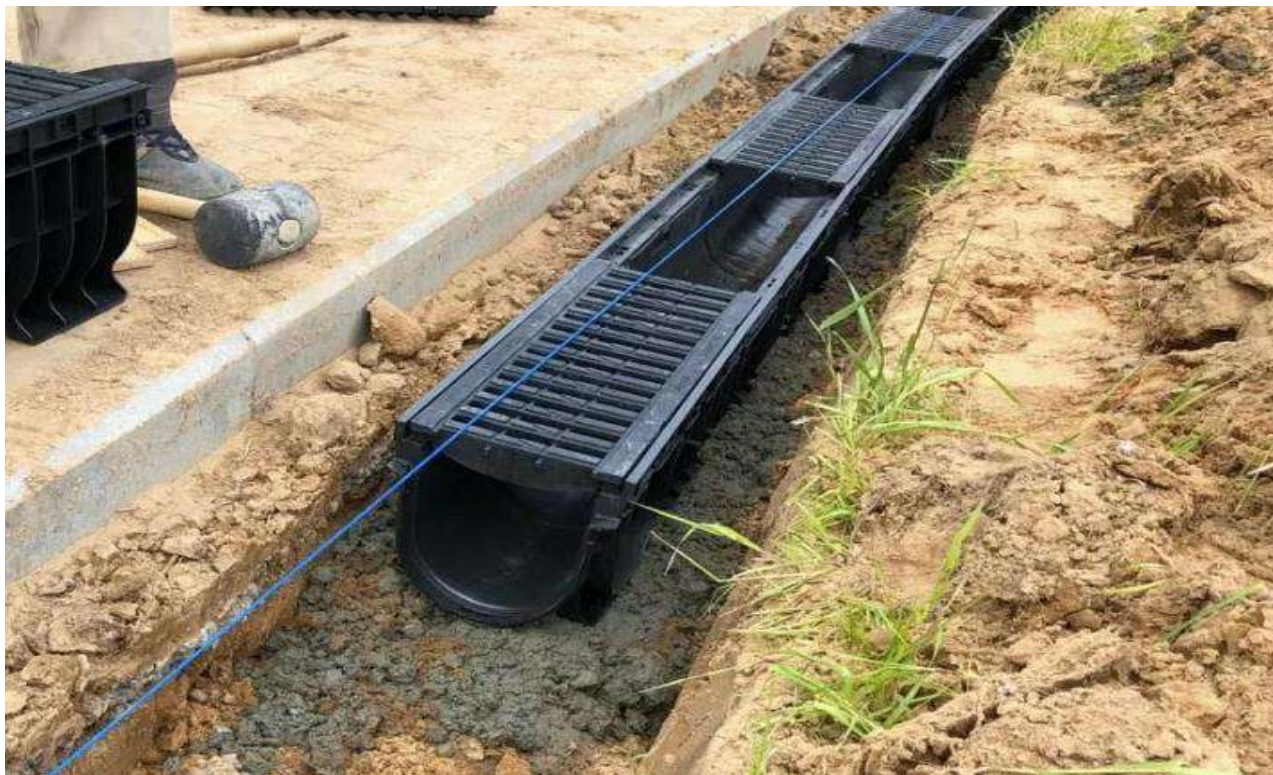
Рис. 13.1. Реконструкция участка сети дождевой канализации
