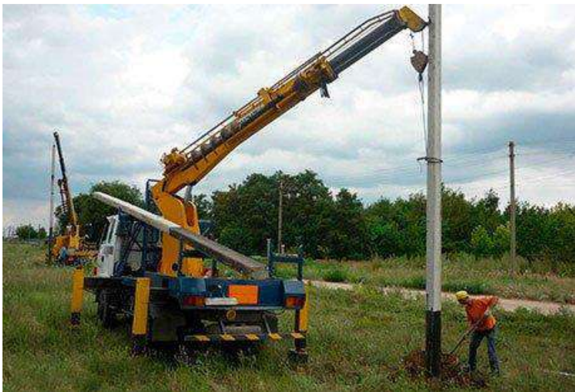
Рис. 13.5. Монтаж уличного освещения (Калининградская обл.)
