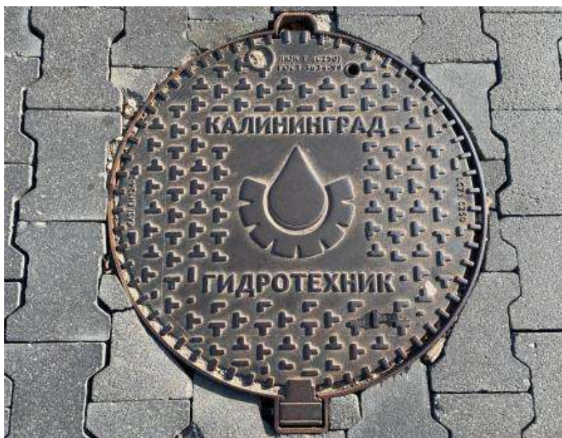
Рис. 13.2. Канализационный люк МБУ «Гидротехник» ГО «Город Калининград»
