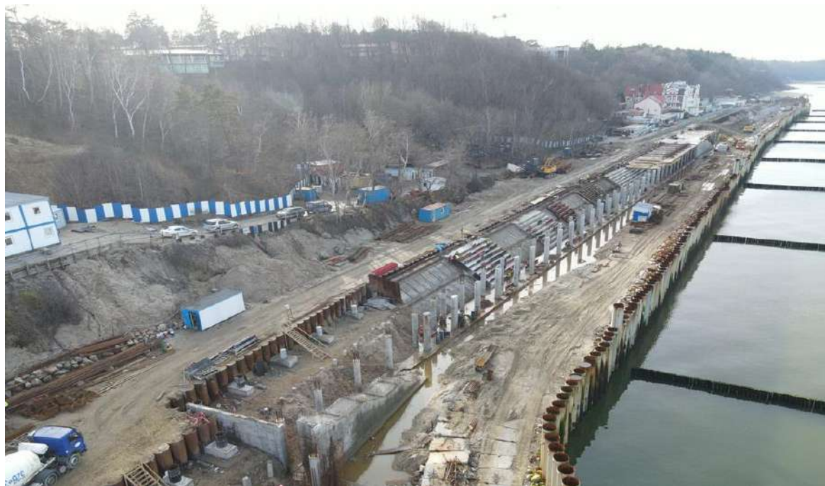
Рис. 3.18. Реконструкция набережной в г. Светлогорске
