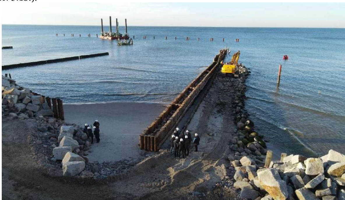
Рис. 3.19. Работы по строительству объекта «Строительство пляжеудерживающих сооружений в районе пос. Отрадное - г. Светлогорск, Калининградская область (2 этап. Строительство пляжеудерживающих сооружений и волногасящих пляжей)»
