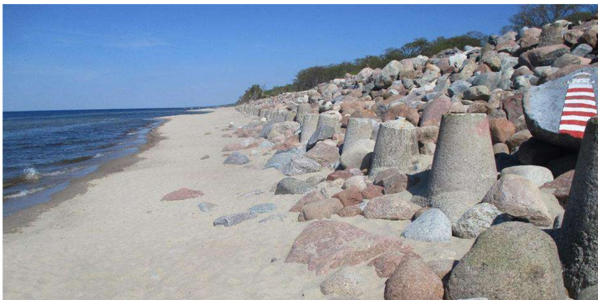
Рис. 3.16. Участок восстановленной и укрепленной авандюны на прикорневом участке Куршской косы
