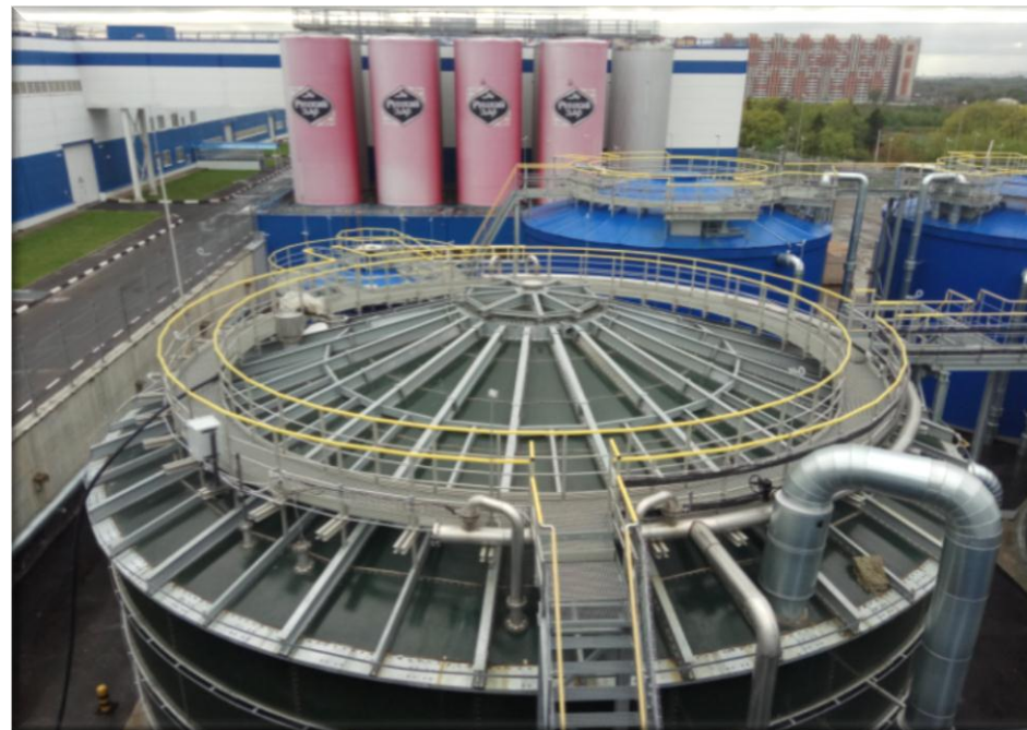
Биологическая очистка реализована на базе мембранного биореактора
